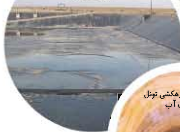
لاکون های تصفیه خانه شهرک صنعتی چرمشهر ورامین
